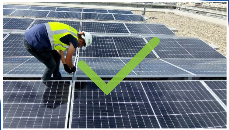
*Paneller arası açıklıkların artmaması için tork kontrolleri yapılarak bu sorunun önüne geçilmektedir.
